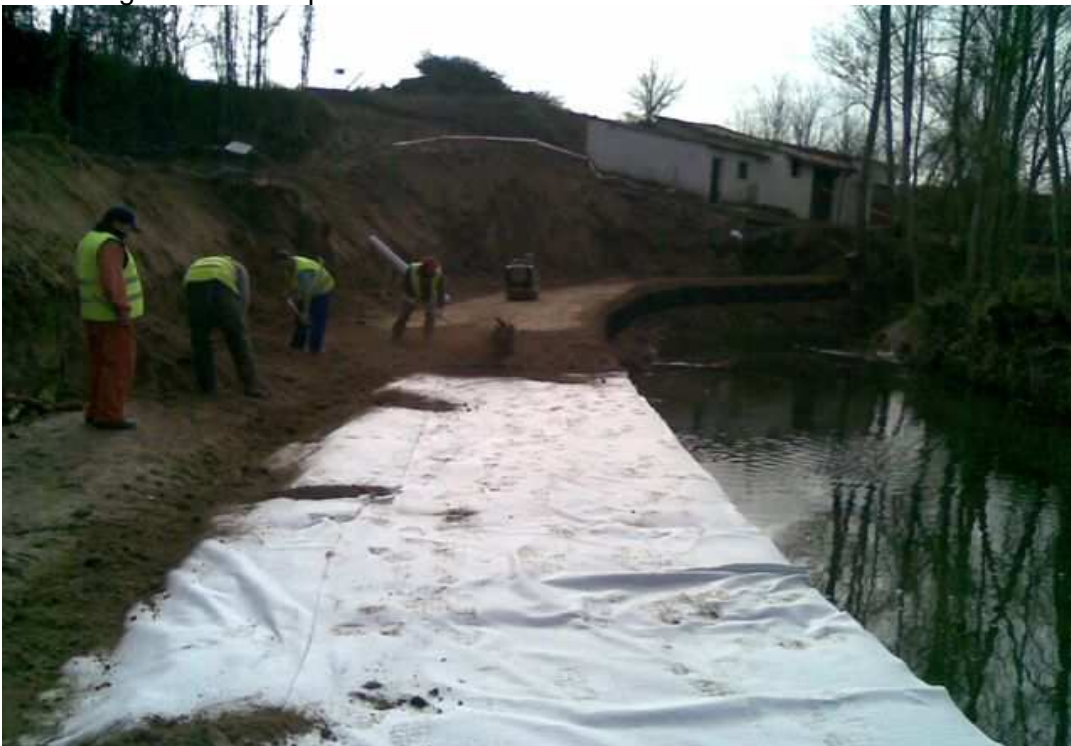
Geotextil sobre los geocolchones para evitar paso de finos
