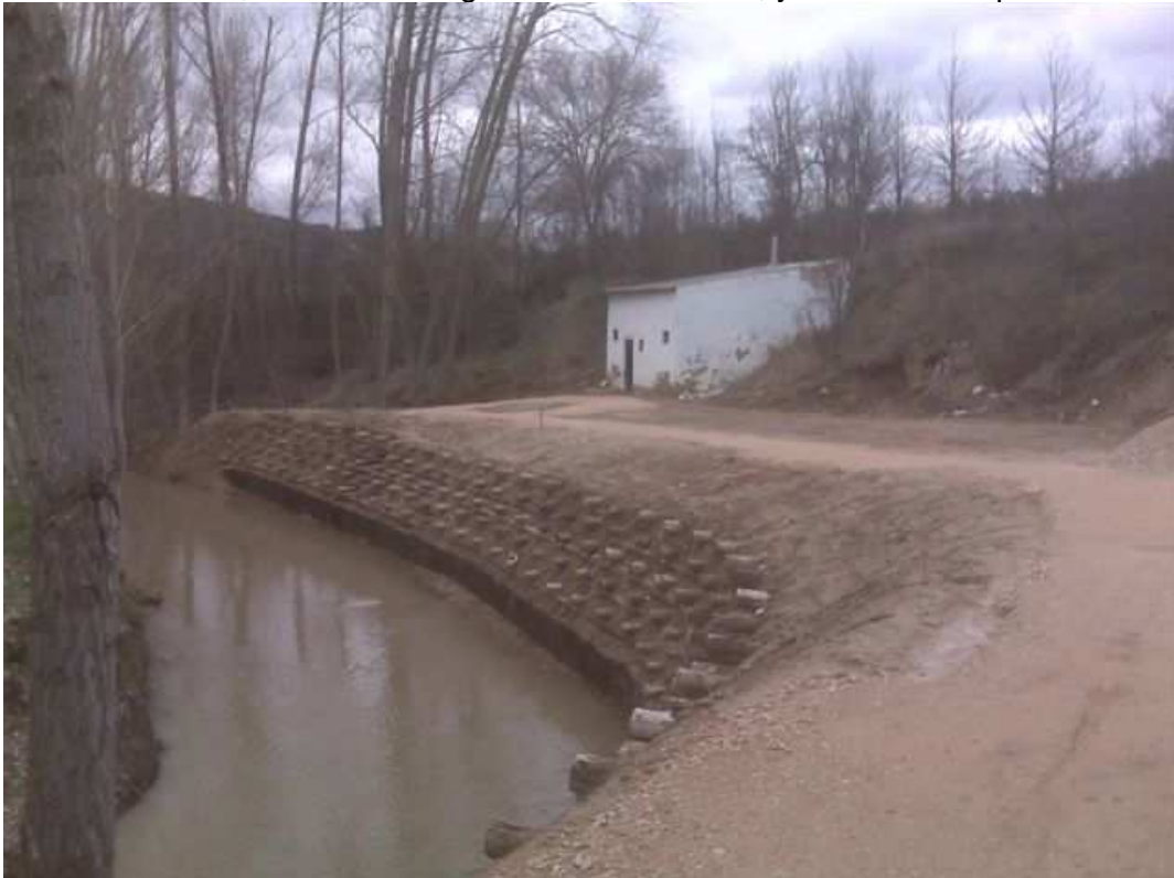
Estado final del muro. Marzo 2010.
