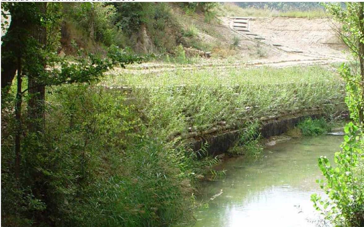
Estado final del muro. Septiembre 2010
