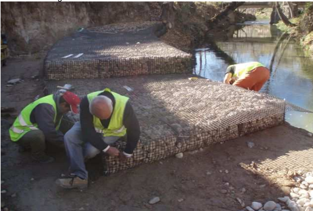
Cosido de los geocolchones con hilo de polietileno.
