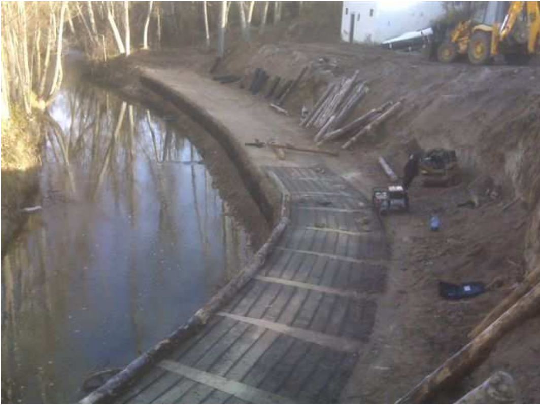
Primeras líneas de troncos longitudinales, con las geomallas uniaxiales.
