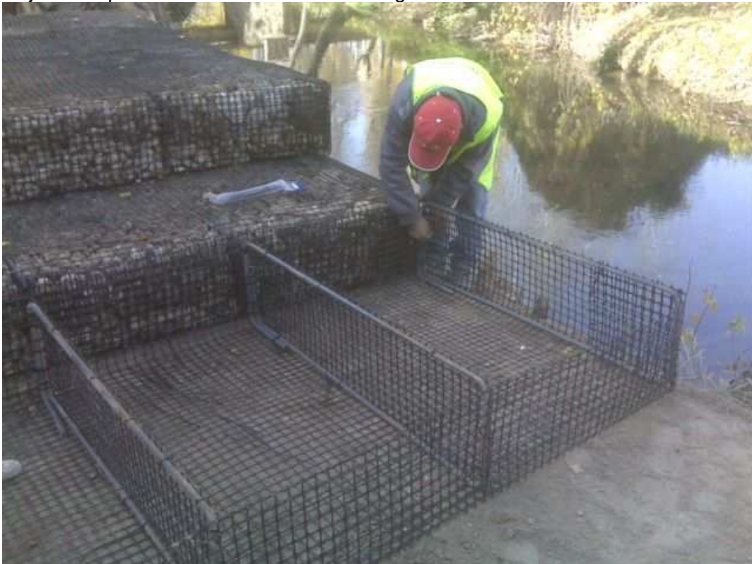
Construcción de geocolchones y montaje.
