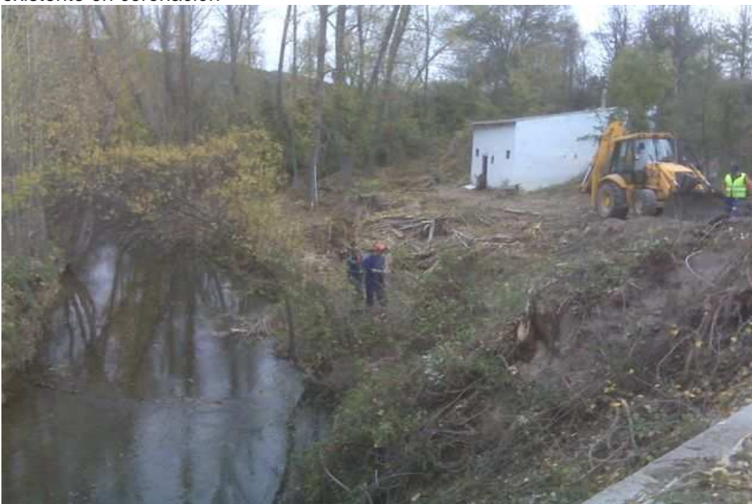
Inicio de los trabajos de apeos y cajado para asiento del muro.
