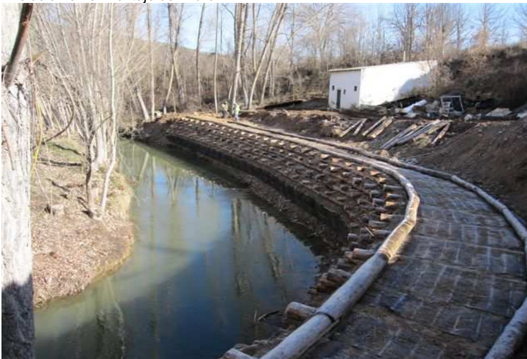
Muro en ejecución; 4 pisos construidos.
