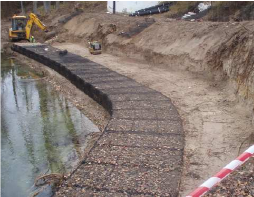
Base de geocolchones prácticamente finalizadas.
