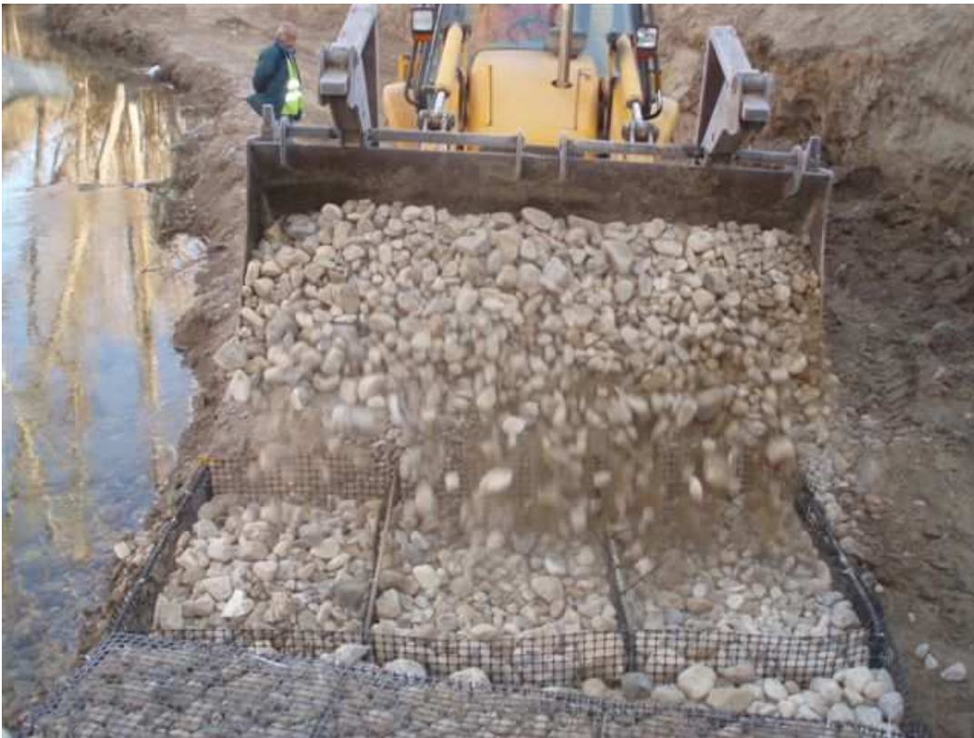
Relleno de los geocolchones
