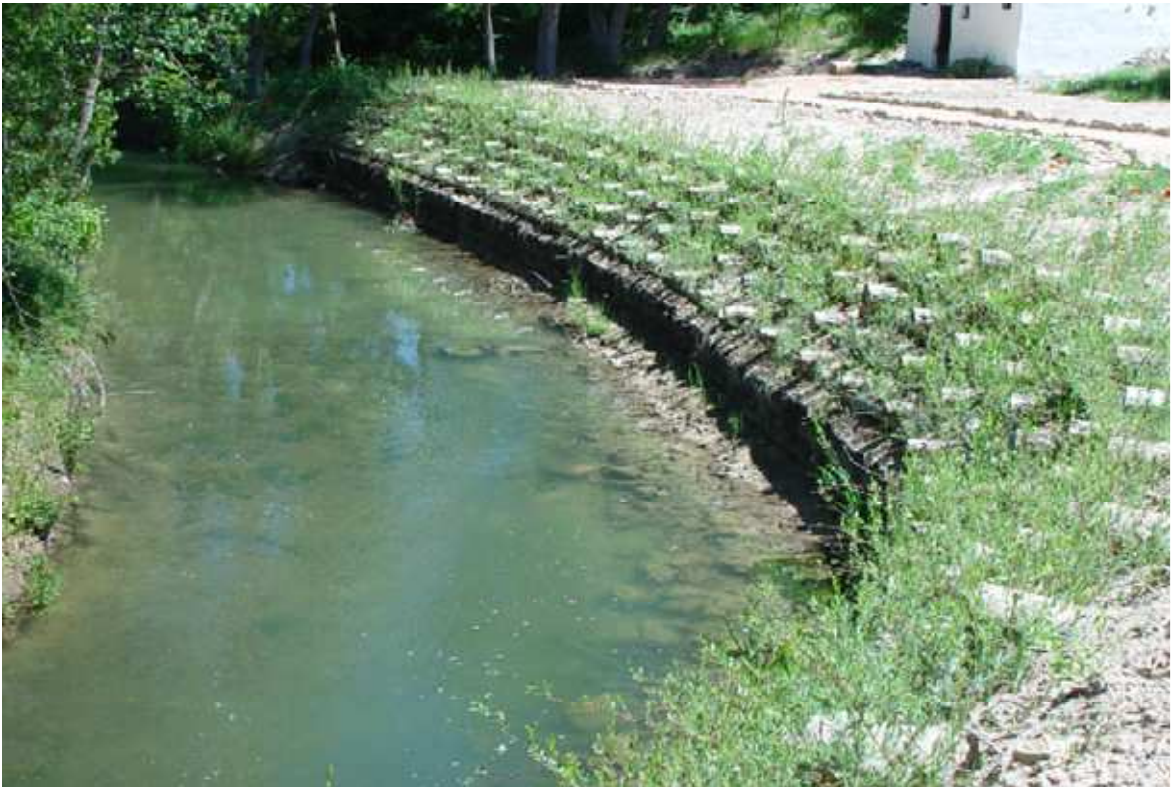
Estado final del muro. Junio 2010.
