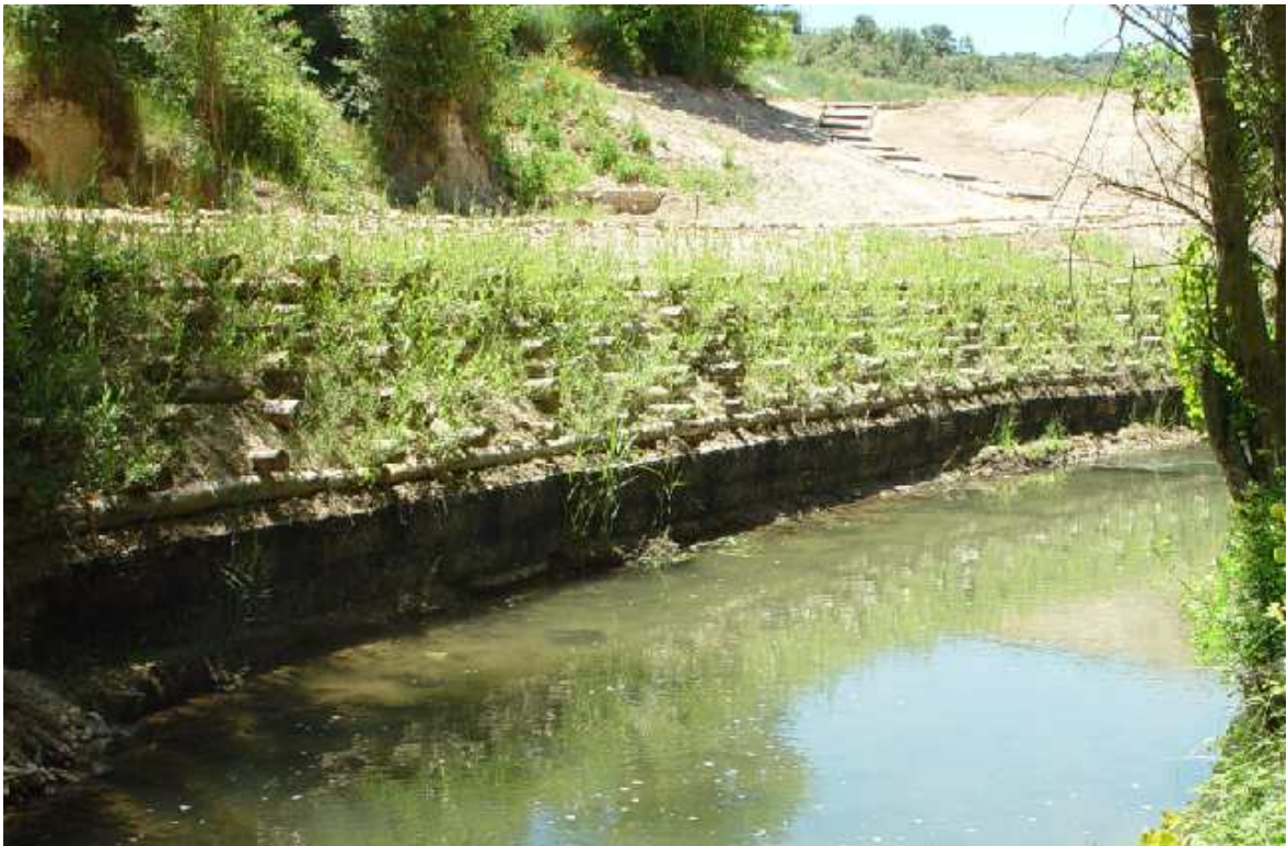
Estado final del muro. Junio 2010
