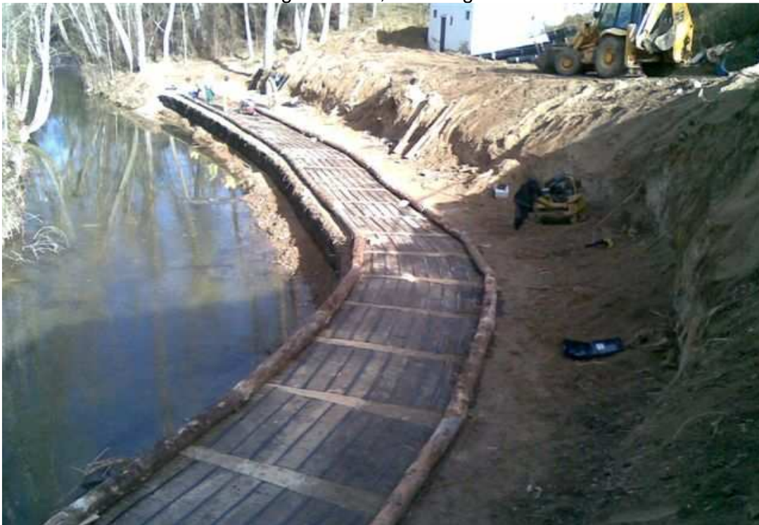
Primeras líneas de troncos longitudinales, con las geomallas uniaxiales.
