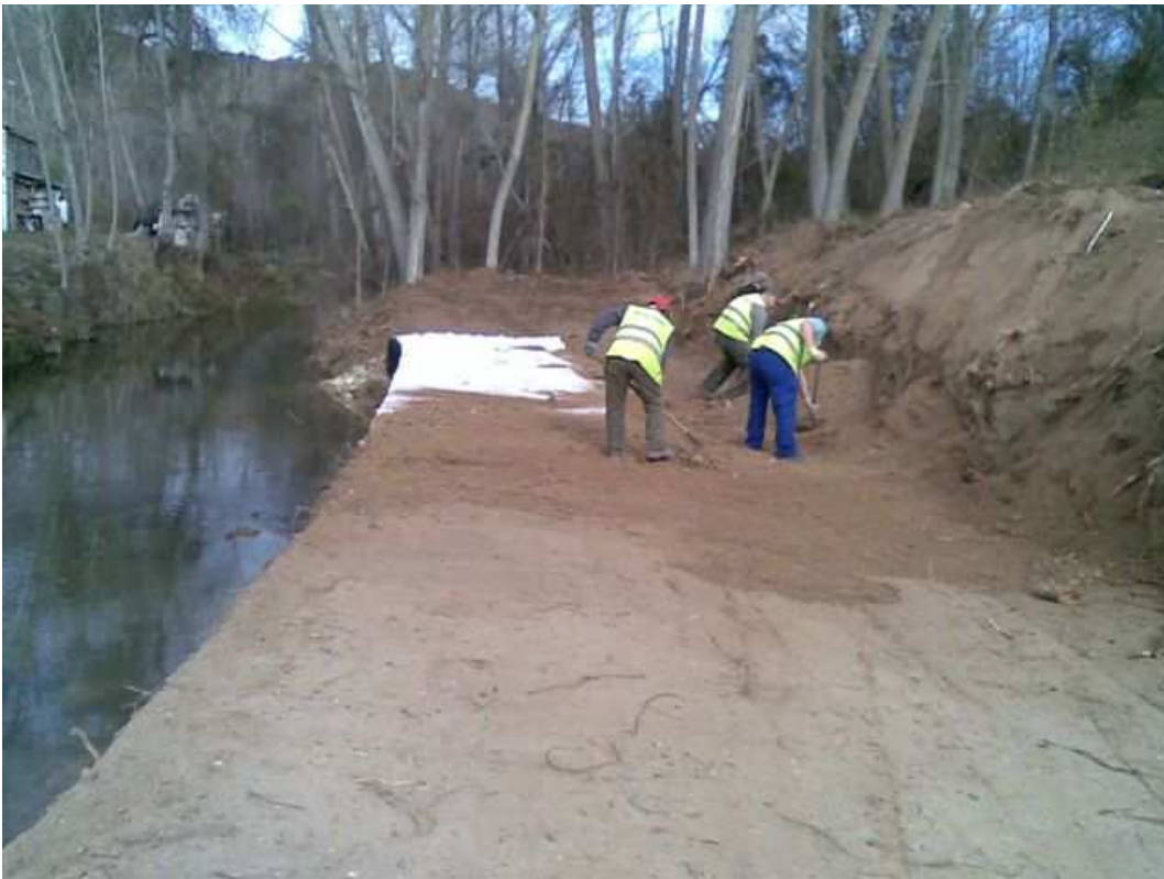
Tapado del geotextil para recibir primera línea de troncos y geomallas.
